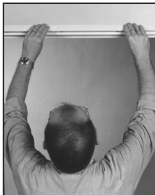
7 Encaje a presión el chambranas del cabezal.
