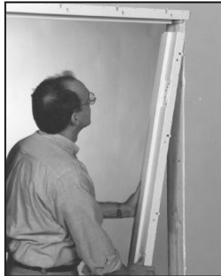
2 Fije el largueros de bisagra sobre la seccion de la pared.
