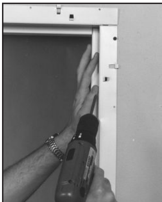
5 Aplique los sujetadores empezando por la parte superior del largueros de bisagra.
