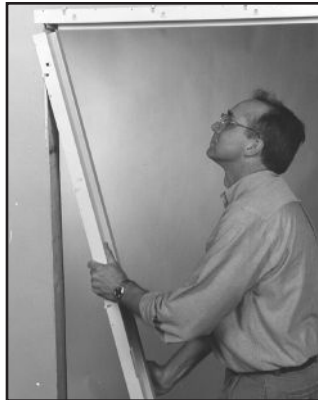
3 Fije el largueros punzonado sobre la seccion de pared.
