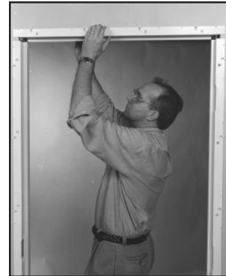
4 Hale hacia abajo el cabezal. Fije bisagras y cuelgue la puerta.
