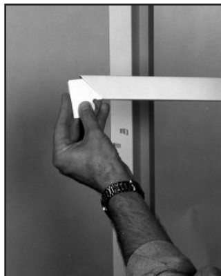
6 Inserte el esquinero en ángulo en el chambranas del cabezal.
