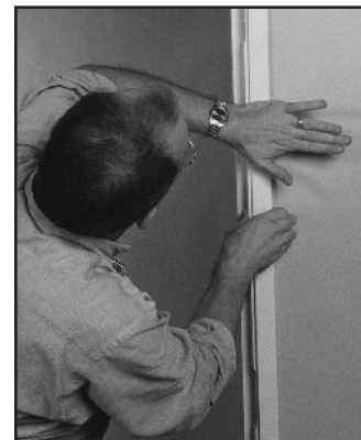
8 Deslice el chambranas del largueros lateral en el esquinero. Alinee con los sujetadores del largueros y encaje a presión.
